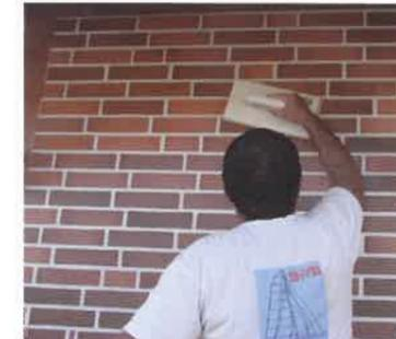
8. LIMPIE EL EXCESO DEL MORTERO DE REJUNTEO CON AGUA LIMPIA Y UNA LLANA DE ESPONJA Y EXPRIMA BIEN UTILIZANDO UNA CUBETA CON RODILLOS Y LIMPIANDO SIEMPRE EN HORIZONTAL Y EN LA MISMA DIRECCIÓN CAMBIANDO EL AGUA CON FRECUENCIA HASTA DEJAR LA SUPERFICIE COMPLETAMENTE LIMPIA.
