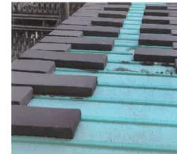
6. APLIQUE LAS PLAQUETAS KLINKER CARAVISTA, EMPEZANDO POR LAS ESQUINAS Y COMPROBANDO LA ALINEACIÓN DE LAS JUNTAS VERTICALES.
